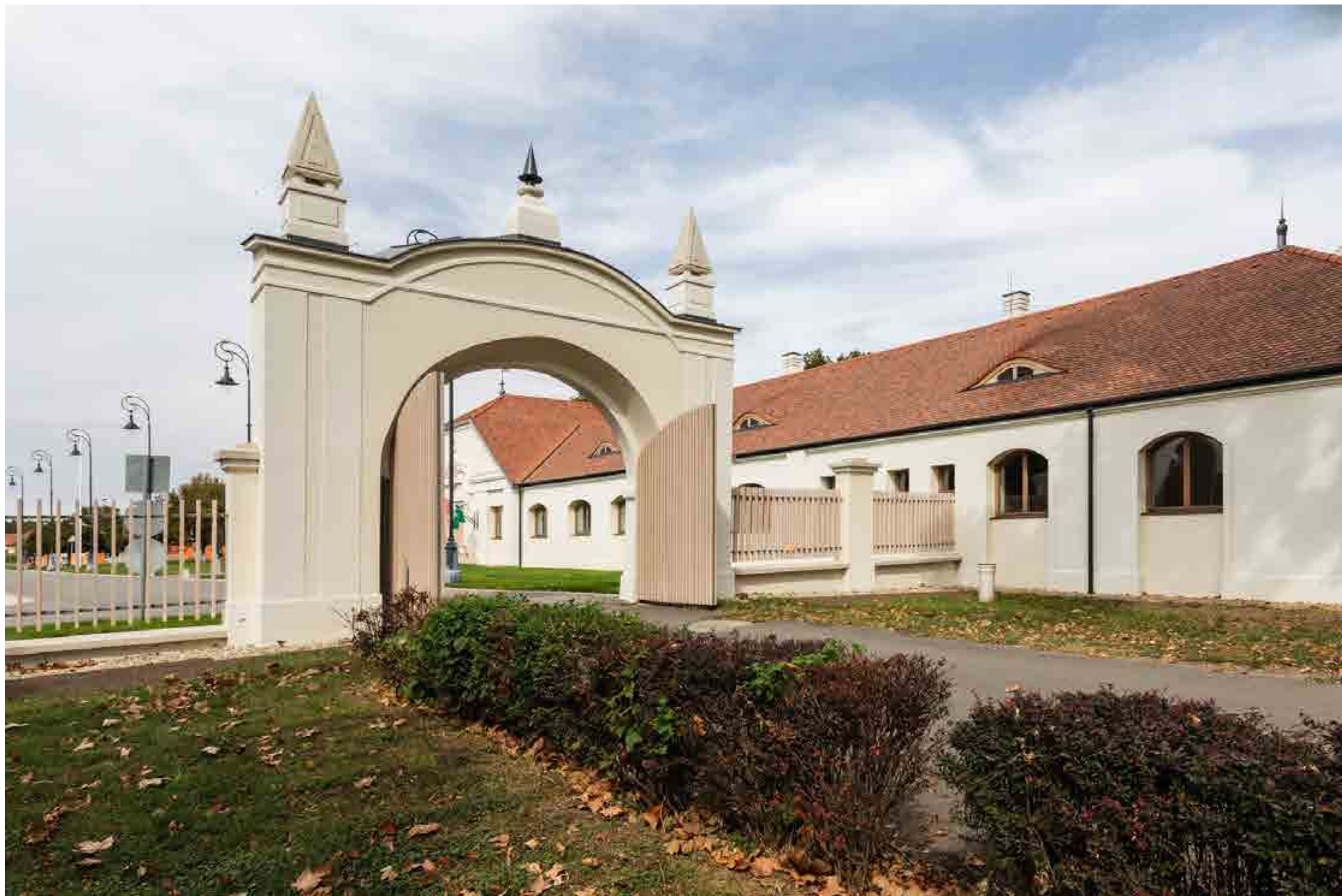
Főépítész beszámoló - A „Hild-kapu” - felújított állapotában
