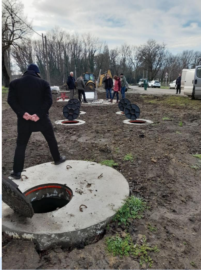
8. kép Átemelő és környezete
