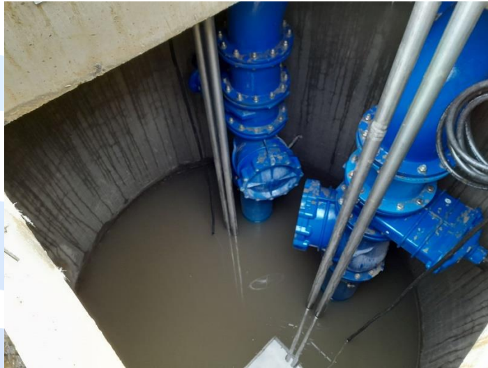
7. kép Átemelő szerelvényezése
