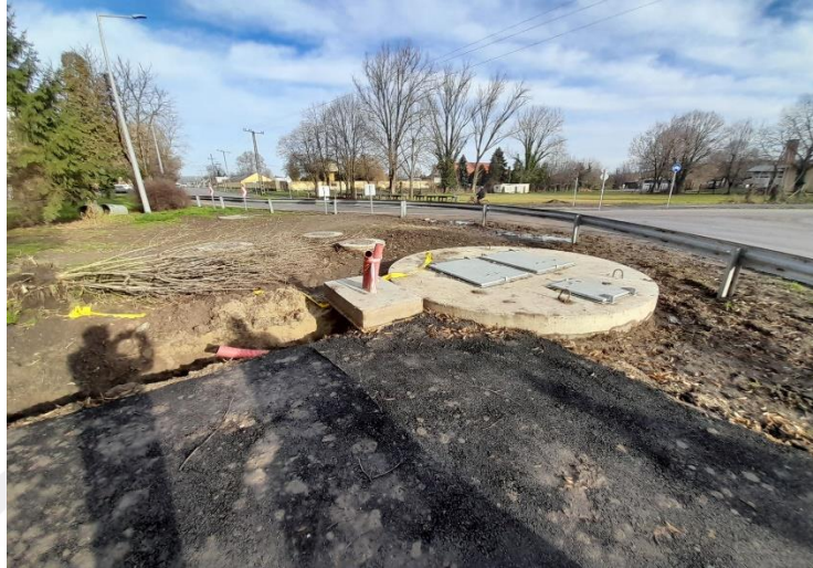
6. kép Átemelő és környezete
