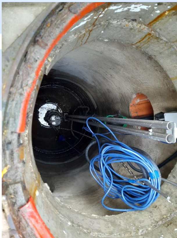
3. kép Átemelő szerelvényezése
