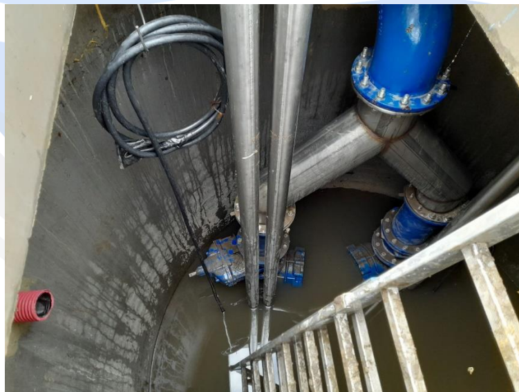
9. kép Átemelő szerelvényezése
