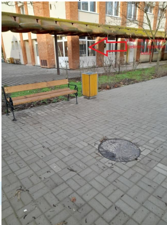
2. kép Átemelő és környezete
