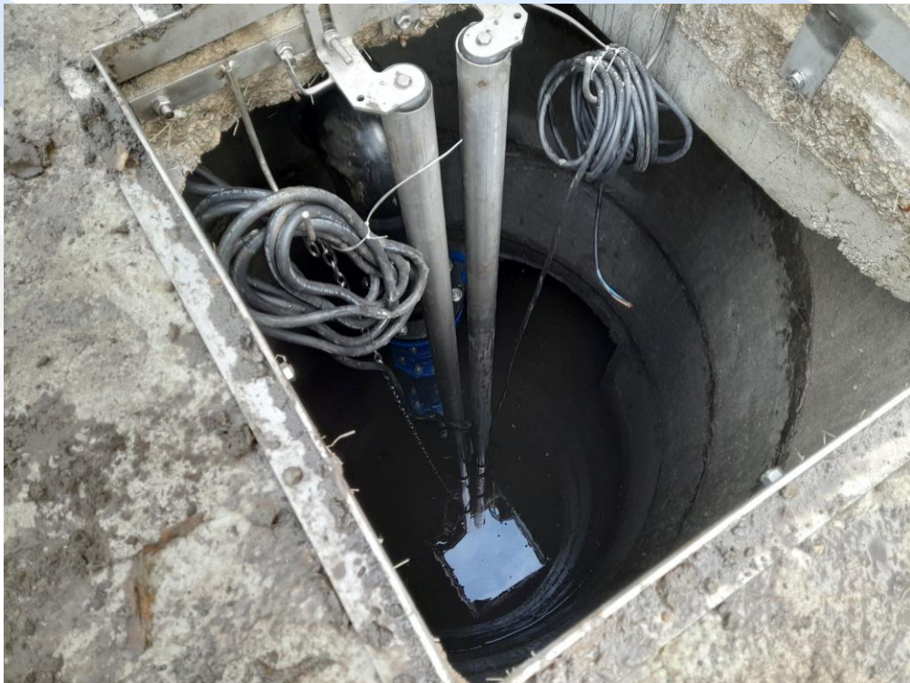
5. kép Átemelő szerelvényezése
