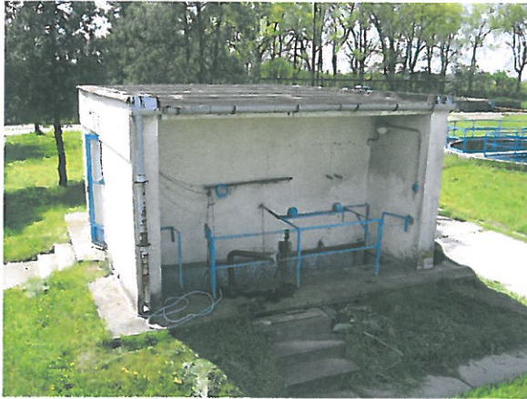
Iszaprecirkulációs gépház
