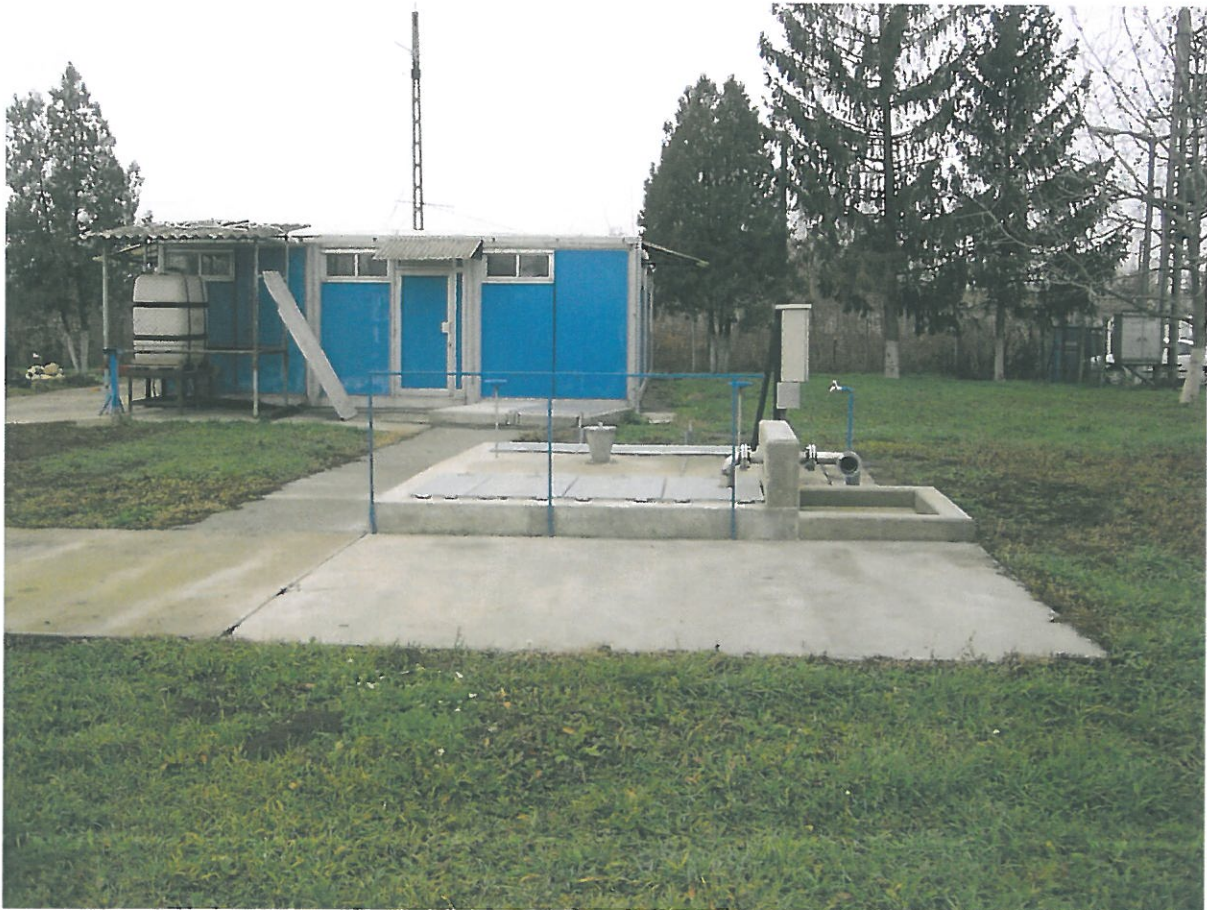
Szippantott szennyvíz fogadó és kezelőépület (konténer)
